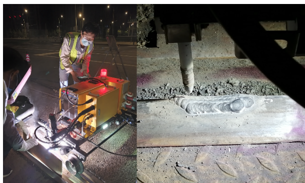
图6 钢轨多图形堆焊现场作业
